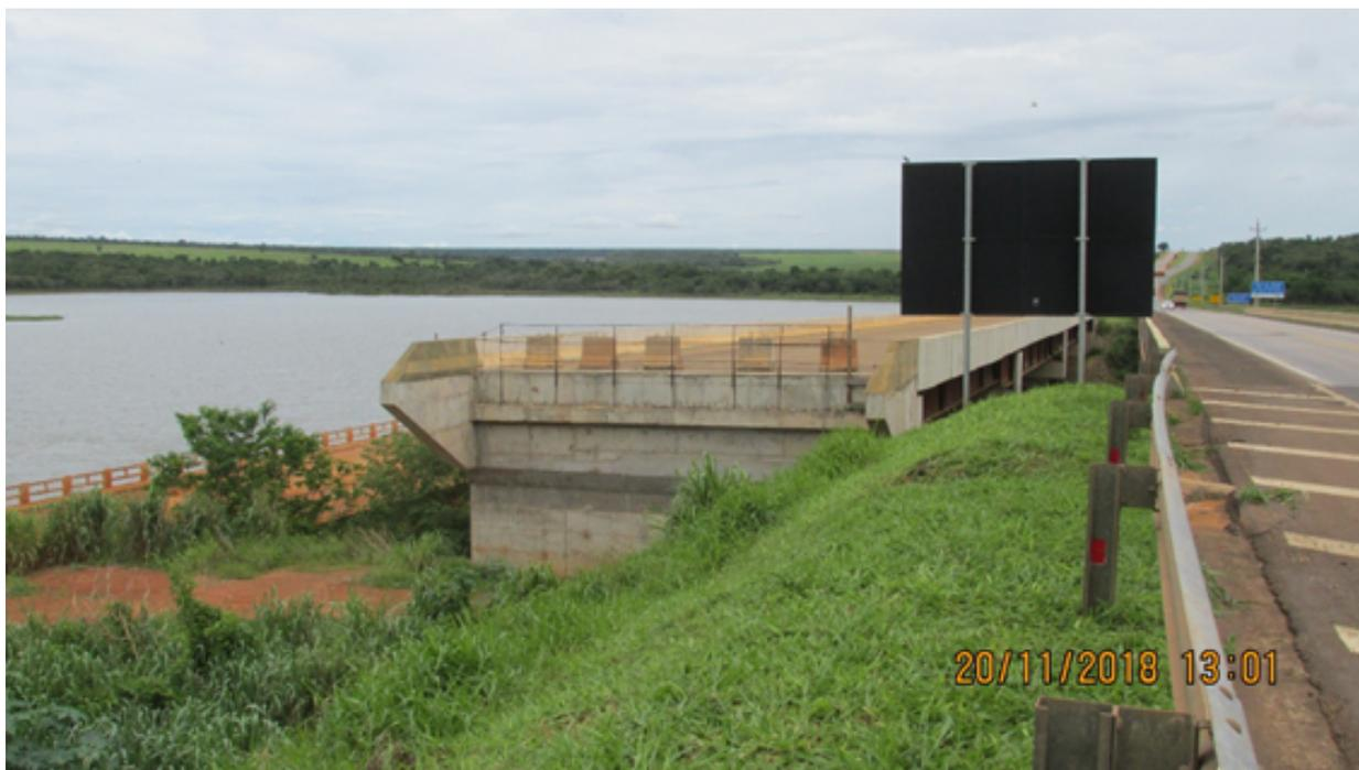
Figura 5 - Vista do final da Ponte sobre o Rio Correntes já na MSVia (divisa MS/MT), faltando laje de transição e encaixe na pista (simples) da MSVia
